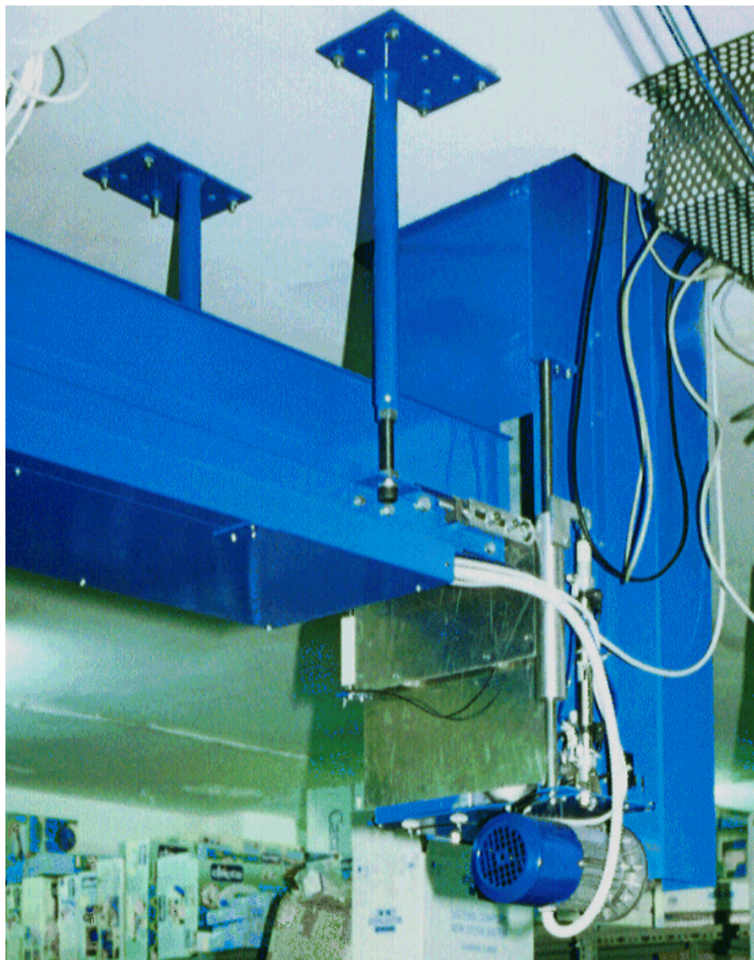
Foto 4 Esempio di lift
